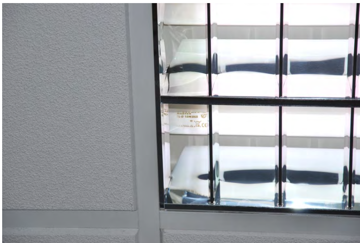
Figura 3-10 Dettaglio plafoniera scuola elementare con neon 18 W x4
