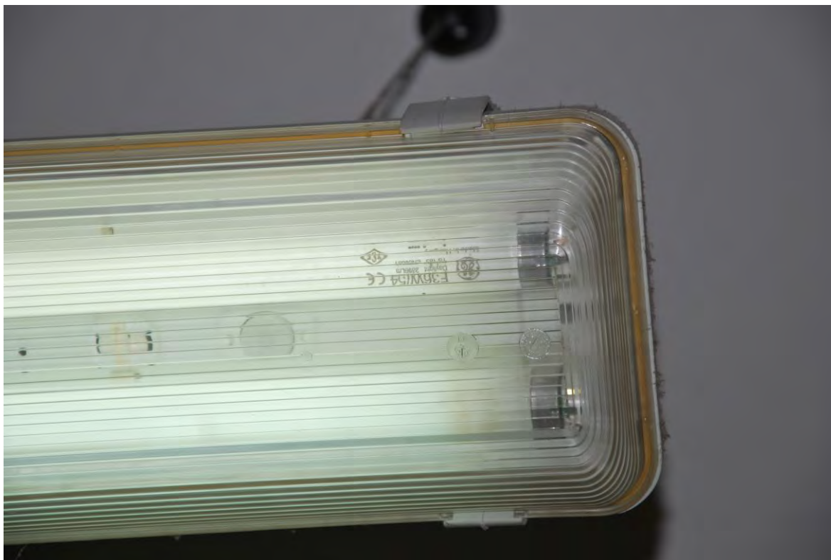
Figura 3-8 Dettagli dell'illuminazione aule – Plafoniere con neon T8 36 W
