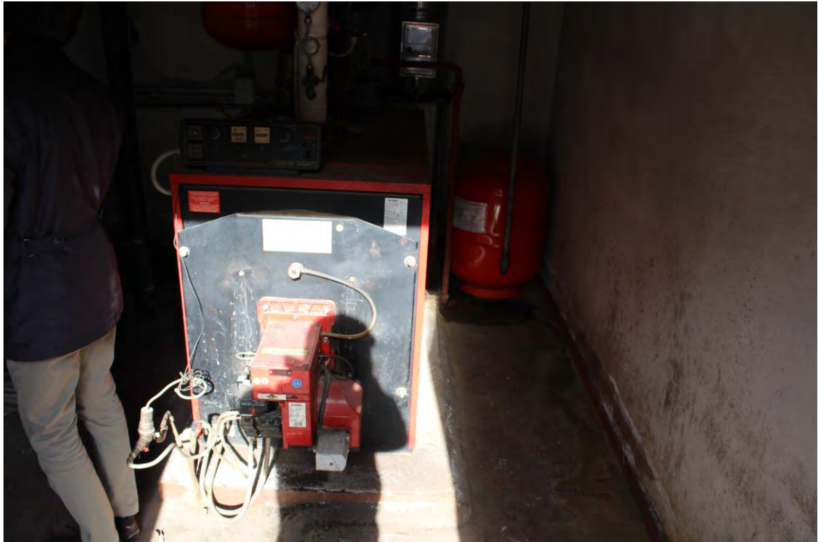
Figura 3-15 Generatore di calore in centrale termica
