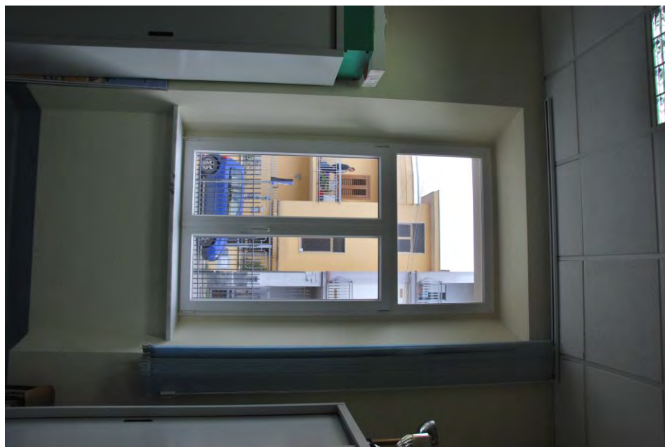
Figura 3-21 Dettaglio degli infissi in pvc scuola elementare
