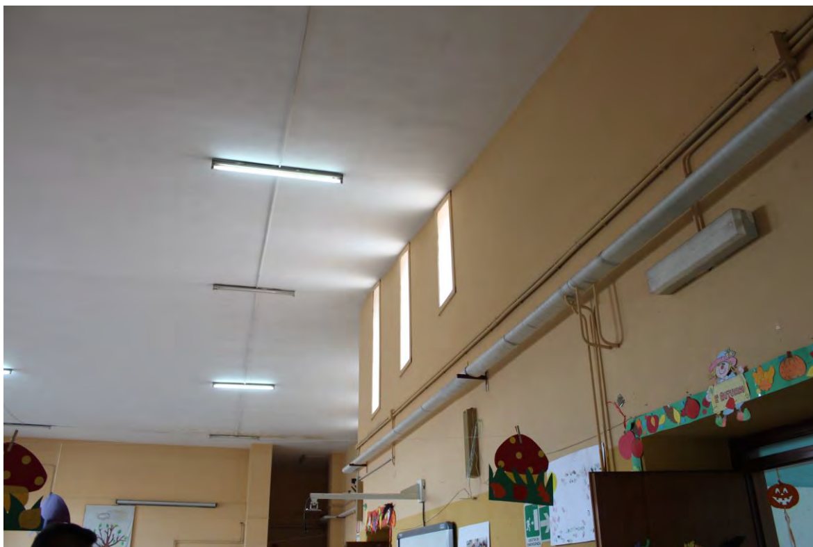
Figura 3-9 Dettaglio illuminazione atrio scuola materna - Plafoniere con neon T8 36 W
